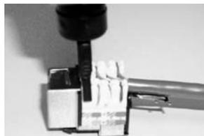
Seguite la direzione sull'etichetta identificativa del colore sulla posizione di cablaggio T568A o T568B, separate un piccolo spazio sulla posizione adeguata ed inserire il cavo a coppie in ogni ingresso. Utilizzare l'attrezzo ad impatto 110 o KRONE e tagliare via ogni conduttore.
