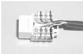
Seguite la direzione sull'etichetta identificativa del colore sulla posizione di cablaggio T568A o T568B, separate un piccolo spazio sulla posizione adeguata ed inserire il cavo a coppie in ogni ingresso.
